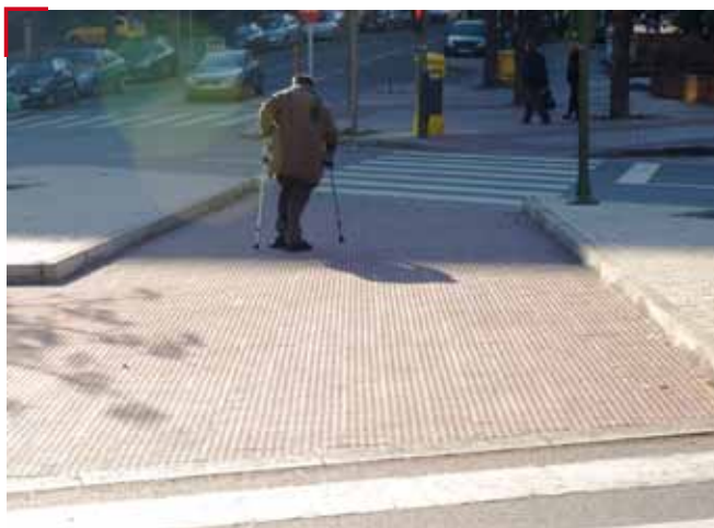
Fig. 12: Una pavimentación completa de la isleta con baldosa de botones puede limitar los beneficios de guía y advertencia de la señalización táctil.
