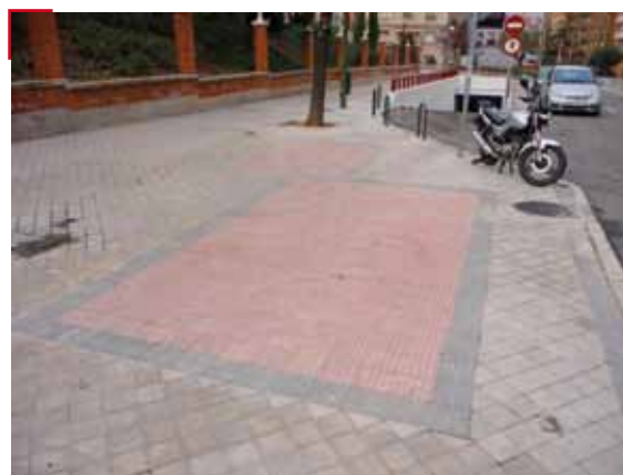
Fig. 11: El uso excesivo de la pavimentación táctil también conduce a vaciar su significado generando aplicaciones simplemente ornamentales o de otro tipo.
