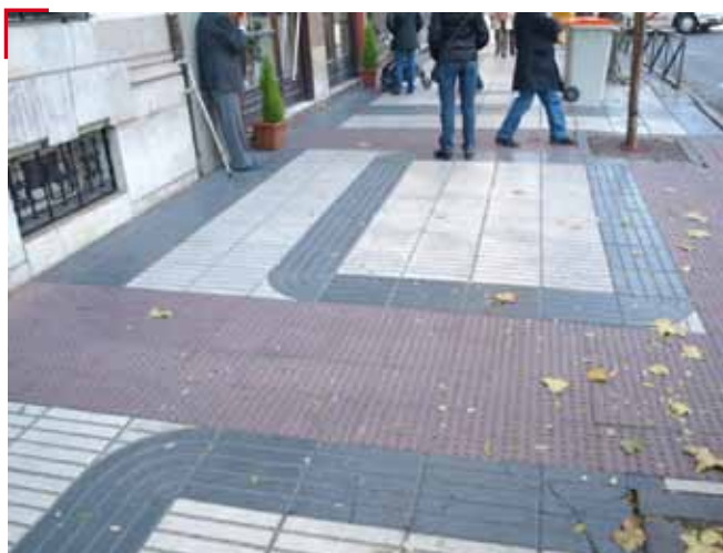
Fig. 14: La profusión de colores y formas en los pavimentos dificultan la utilización del contraste como código de orientación.
