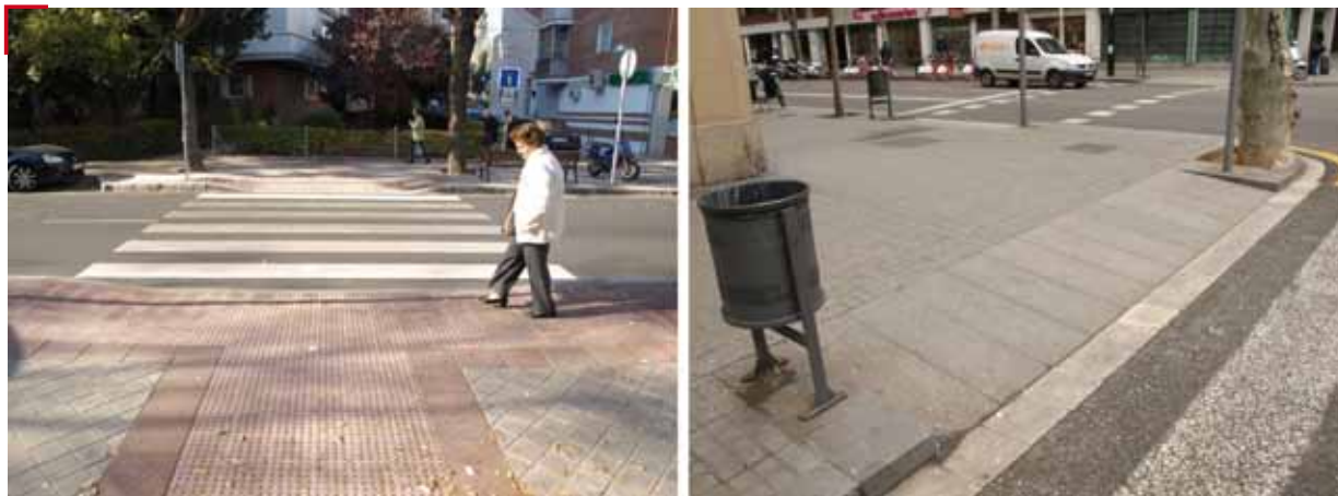
Fig.3a y 3b: los modelos característicos de vado de Madrid y Barcelona marcan dos formas muy distintas de abordar las soluciones de accesibilidad necesarias en un cruce.
