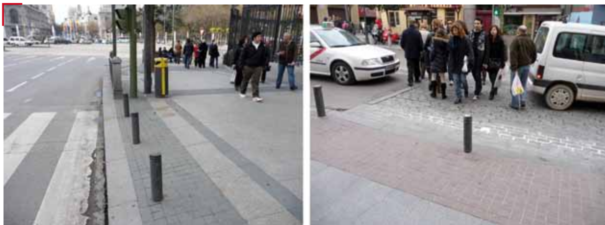
Fig. 8a y 8b: Falta de uniformidad del pavimento táctil y dificultad de discriminación entre materiales. Las soluciones no estandarizadas en zonas escogidas de la ciudad, pueden resultar más estéticas, pero son poco efectivas.
