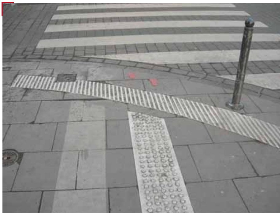
Fig.4: La falta de estandarización en el uso de la señalización táctil genera diferentes códigos en países, regiones y ciudades. En la foto, sistema de señalización de paso de peatones en Colonia, Alemania.
